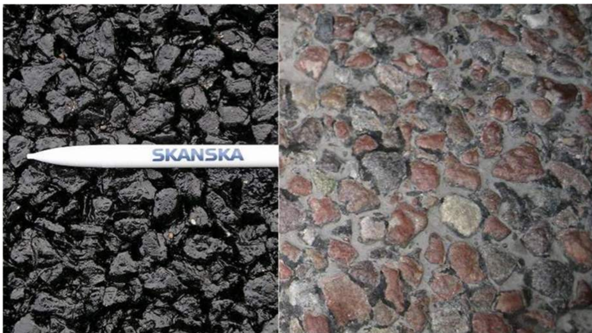
Figur 17. Öppen (vänster) samt igensatt (höger) beläggning.
