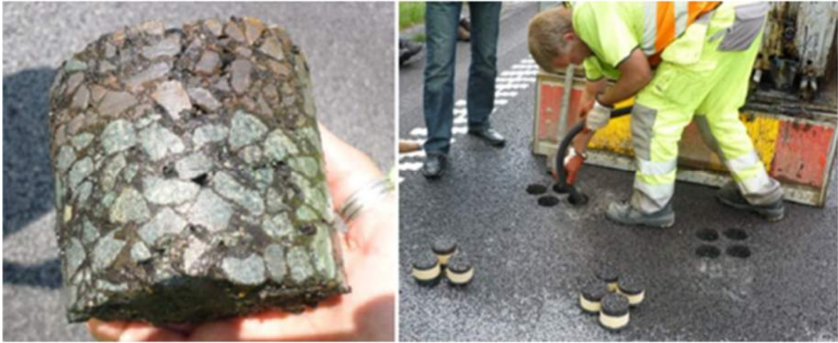
Figur 24. Borrning av provkroppar 2011.
